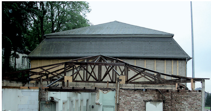
Binderdach eines Nebengebäudes, gut Material-optimiert. Die Baustellenverbindungen stellten weitgehend Hakenverbinder zum Einhängen im Sinne von transportabel her, im Bild der Anschluss des Nebengebäudefirstes an die Hallenwand. Die Dachschalung war mittels Latten zu Elementen vorgefertigt.
