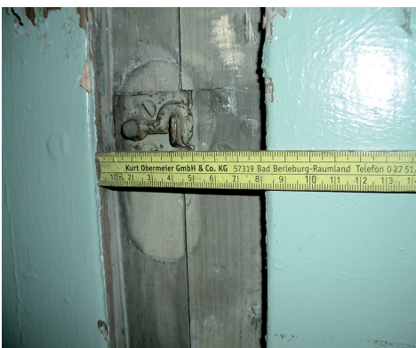
Koppelung der Wandelemente, alt mit Hakenverbindung, neu mit modernem Einrastverbinder (Knapp-Ricon), der Kräfte in allen drei Achsrichtungen übertragen kann.
