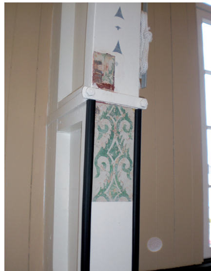
Brüstungsbereich mit Anbindung der Außenstützen durch Klemmung, ohne Querschnittsstörung des Bogenbinders. Hier der Binder, an dem die erste „Dresdener“-Bemalung freigelegt ist. Gut erkennbar ist die Unversehrtheit des B5-Holzes.
