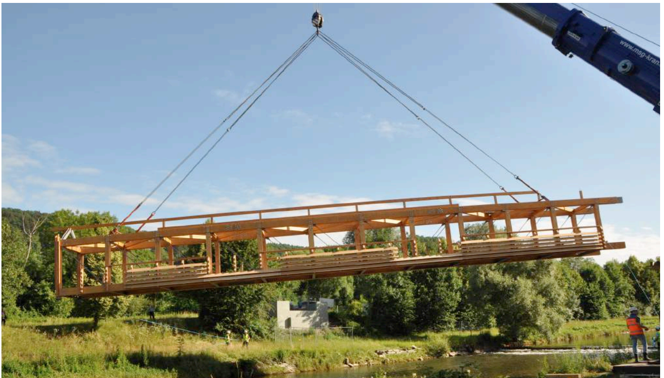
Bild 17: Montageabschnitt 3 beim Einheben
