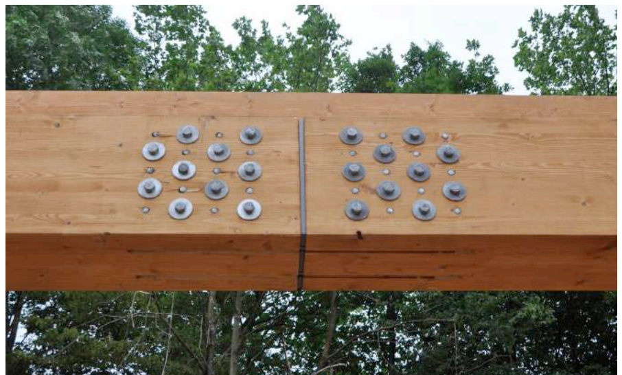
Bild 10: am Bauwerk umgesetzter Gurtstoß
