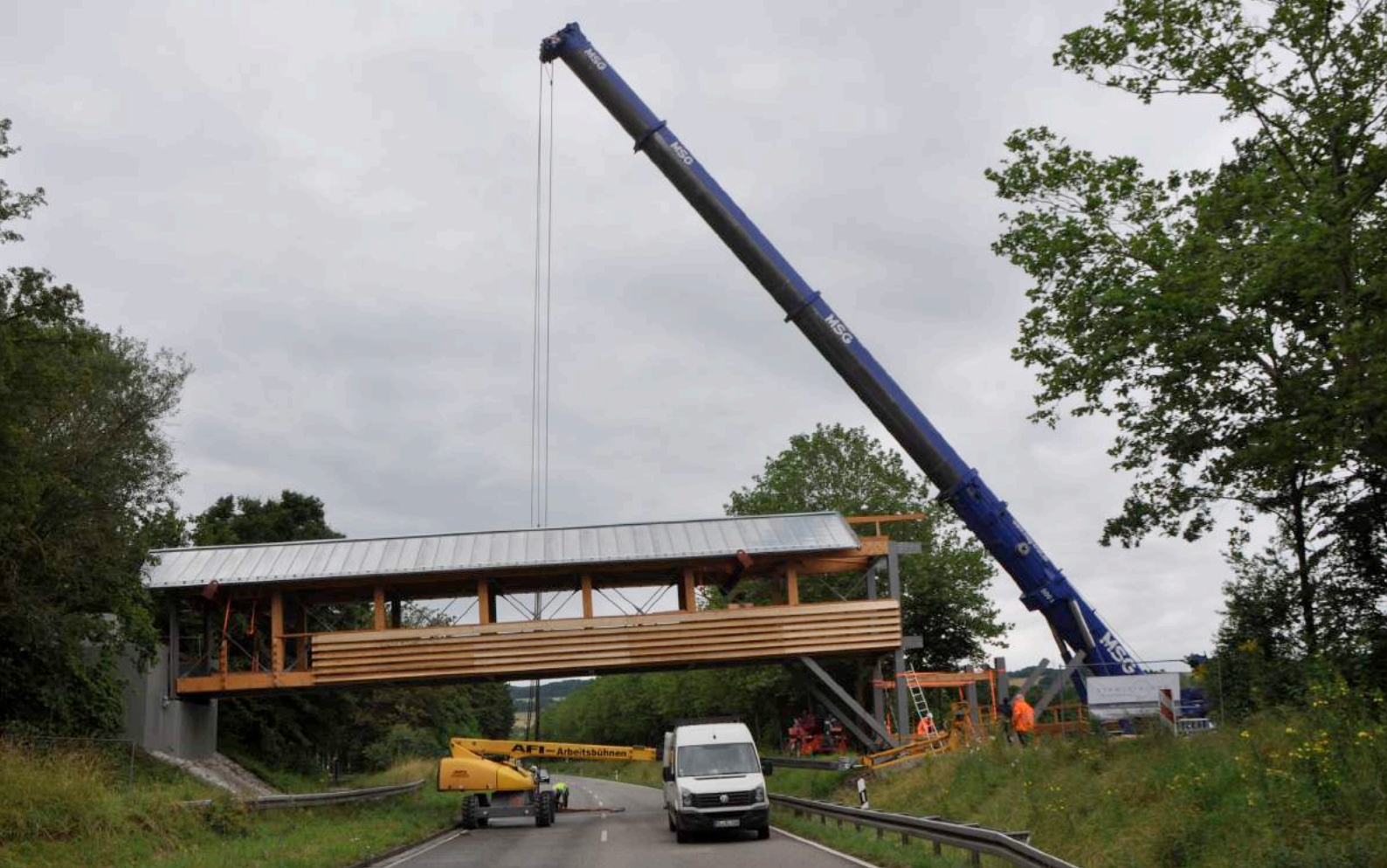
Bild 13: Bereits eingehobener Montageabschnitt 1 über der B317
