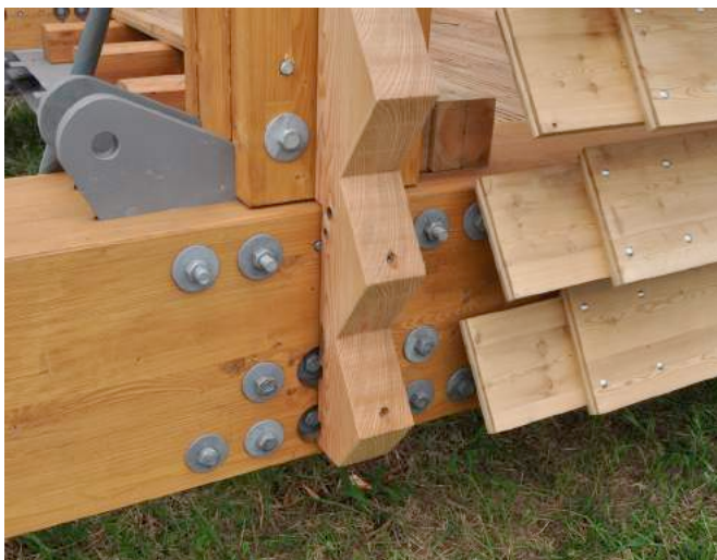
Bild 7: Konstruktiver Holzschutz der unteren Fachwerkknoten
