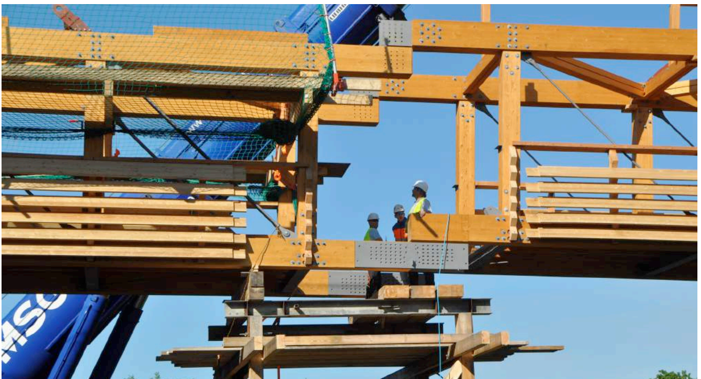
Bild 18: Übergangsbereich zwischen Montageabschnitt 2 und 3
