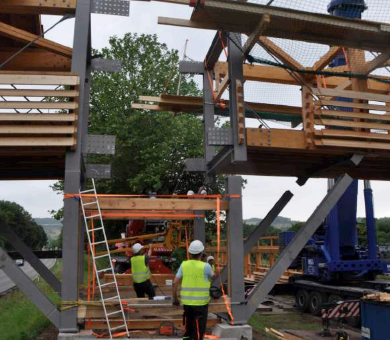
Bild 15: Blick gegen Achse 80 und 90 als Koppelstelle zwischen Montageabschnitt 1 und 2
