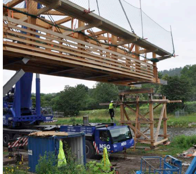
Bild 16: Blick gegen das Montagegerüst zwischen Achse 140 und 150 mit Pressenauflegemöglichkeit
