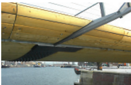
Bild 14 Traverse im „verschalten“ Zustand mit Zugseilanschluss
