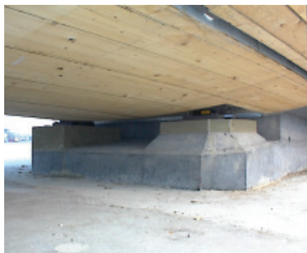
Bild 12 Untersicht auf den blockverleimten Brückenkörper und die Auflagersituation am Stahlbeton-Widerlager
