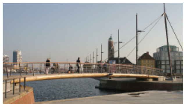
Bild 3 Das alte Trockendock von Lloyd öffnet sich zum Hafenbecken des Neuen Hafens mit einer Breite von etwa 23,5 m, welche die Brücke überspannt. Der Pylon ist mit dem Abspannpunkt über die Brückenmittelachse geneigt.
