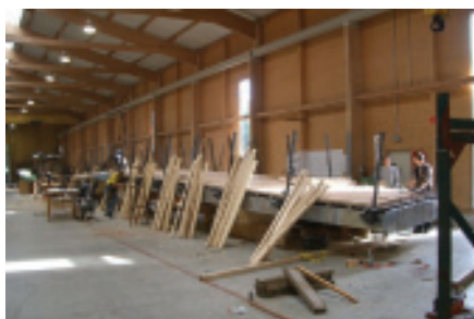
Bild 5 ... Geländerpfosten sowie den Gehbahnaufbau mit dem Bohlenbelag aus Lärchenholz.
