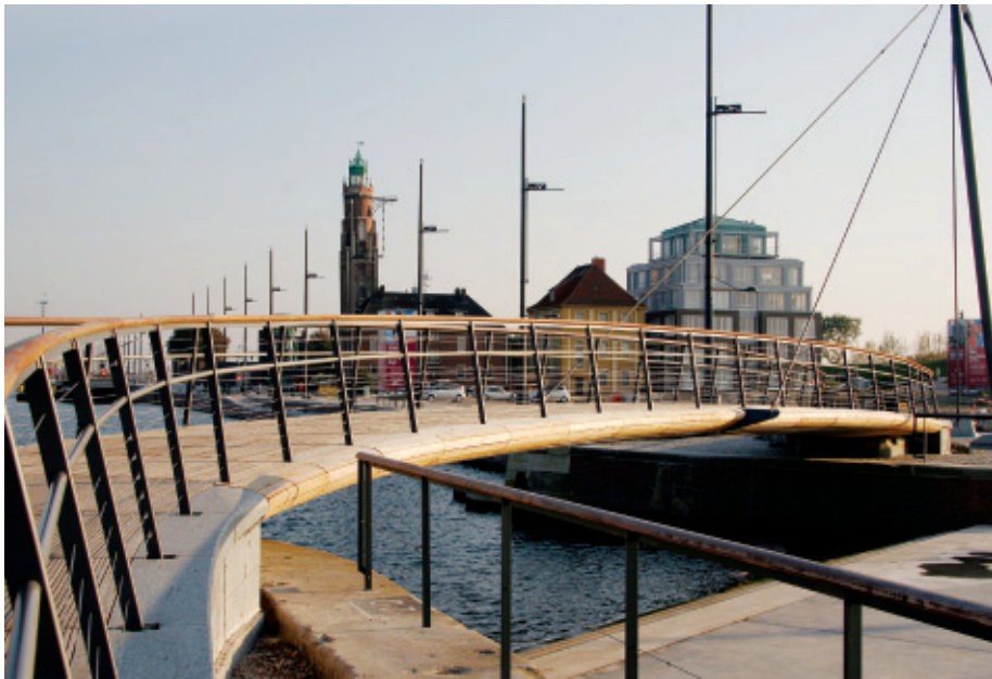
Bild 1 Die beiden Fußgängerbereiche der Kaje sind durch eine S-förmige Brückenplatte und sanfte Rampenübergänge verbunden. Der Brückenkörper soll den Besuchern einen Blickfang bieten.
