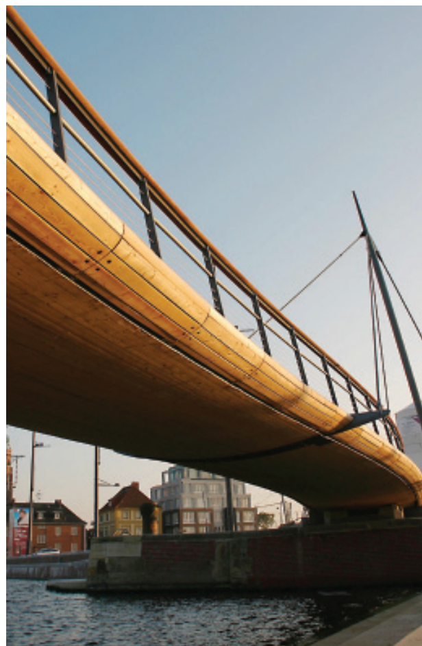
Bild 15 Die Abspannung der Brücke erfolgt über einen Pylon mittels Zugseilen, die zur Brücke hin über auskragende Stahlschwerter mit dem tragenden Brückenkörper verbunden sind.
