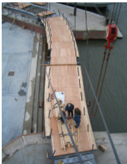
Bild 10 Die im Grundriss S-förmig angelegte Brücke besteht aus drei Teilen: dem hölzernen eigentlichen Brückenkörper und den beidseitig anschließenden Rampen (siehe Bild 13).
