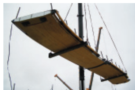
Bild 8 Der Querschnitt des hölzernen Brückenkörpus' nimmt von der Mitte zu den Rändern hin ab. Hier wird er mit dem Kran über Stahltraversen eingehoben.
