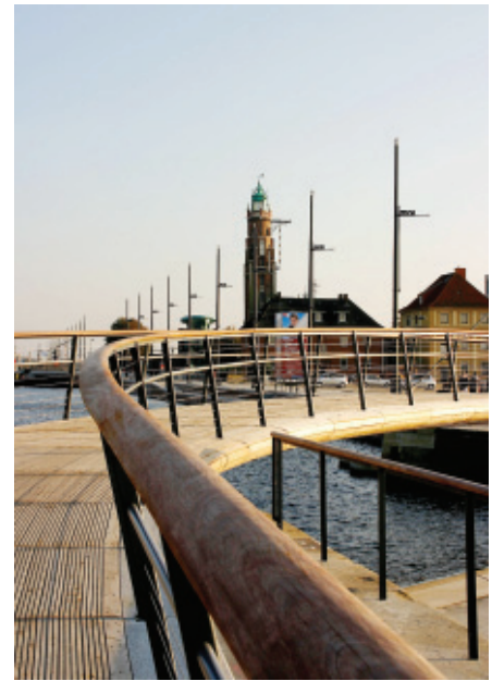
Bild 2 Die Gestaltung der Geländer und des Brückenbelags sind an die Optik eines Schiffsdecks angelehnt und wurden aus Tropenholz und Lärche hergestellt.
