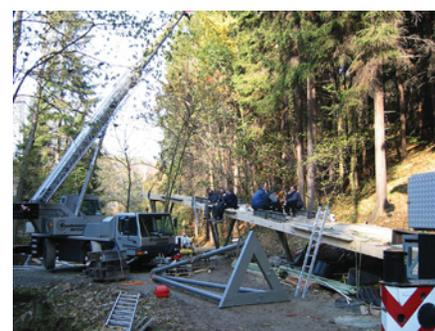
**Bild 9 Die ersten drei Abschnitte sind gerichtet, Zeit für Versper. Hier gut erkennbar, dass die Konstruktion im Bauzustand horizontal nur durch die Einspannung am Widerlager gehalten ist.**
