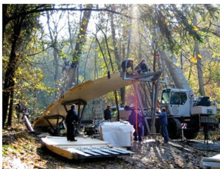
**Bild 8 Einbau von Stütze und Plattenabschnitt drei**
