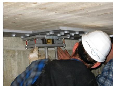
**Bild 14 Das Horizontallager in der Bahnmitte wird angefahren.**
