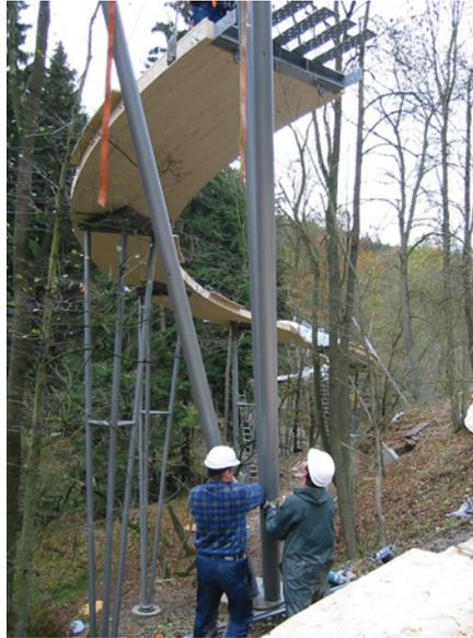
**Bild 11 Die erste Querabspannung ist erreicht: Im Hintergrund die „frisch“ fertig verschraubten Stoßlaschen, in Bildmitte Verschraubung und Abnehmen der Hilfsjustierkonstruktion, vorne hängt das nächste Teil schon über die Montagehilfen gekoppelt an dem ersten Bauabschnitt.**
