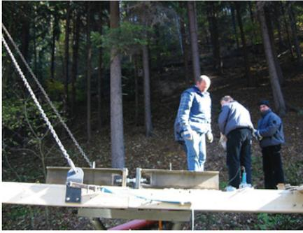
**Bild 10 Koppelungselemente für den Montagezustand: Die I-Profile sind auf die Platten geschraubt, mit den Muttern lässt sich das gegenüber liegende Ende der „neuen“ Platte exakt horizontal „steuern“.**
