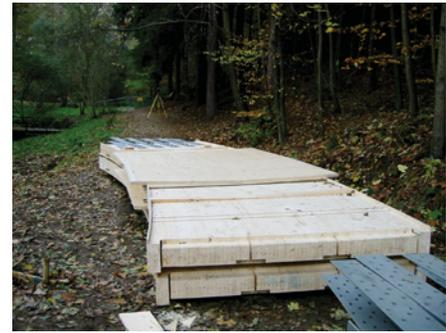
Bild 6 Bogenelemente Montage fertig. Man erkennt, dass die Verwindung wider Erwarten gering ist. Die unterlüfteten Kertoplatten sind in der Mitte schon aufgebracht.
