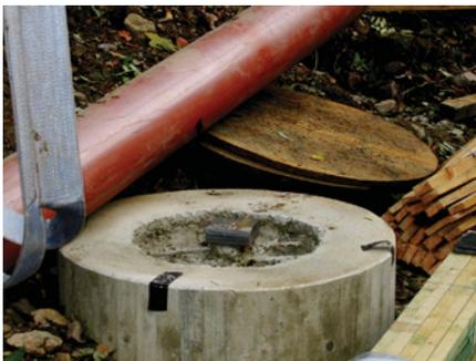
Bild 4 Stützenfundament: Die Stahlplättchen sind genau „auf Höhe“ gelegt ...
