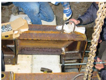
**Bild 7 Hilfskonstruktion zur horizontalen Fixierung der ersten Fahrbahnplatte am Widerlager**
