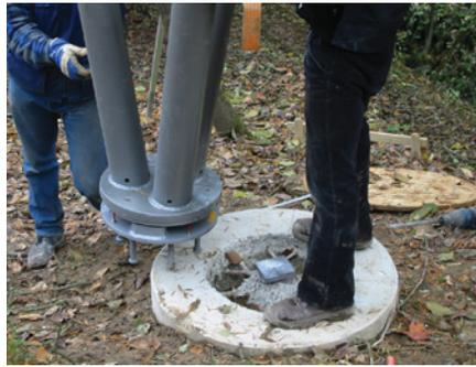
Bild 5 ... und die Stützenverankerung wird in die Aussparung gesetzt und danach ausbetoniert. Die Schrauben zwischen Unter- und Oberlager werden nach dem Setzen der Stütze entfernt.
