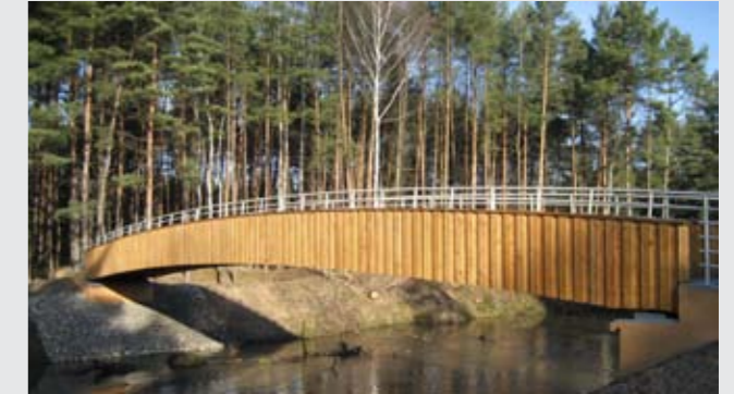
Bild 4 Zawadzkie, Brücke mit der Länge von 26 m, ein Transport und 1 Montagestunde
