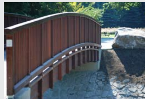
Bild 8 Brücke in Jelenia Góra, Länge 19 m, die Montage dauerte 1 Stunde
