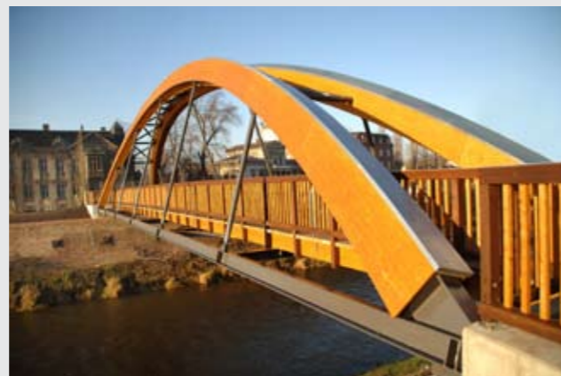
Bild 2 Brücke in Gubin, 38 m Länge. Ein Transport und eine Montagestunde
