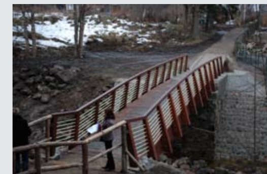
Bild 9 Brücke in Szklarska Poręba, Länge 19 m, die Montage dauerte 2 Stunden
