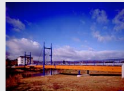
Bild 5 Brücke in Bereldange, Länge 100 m, die Montage dauerte 4 Tage
