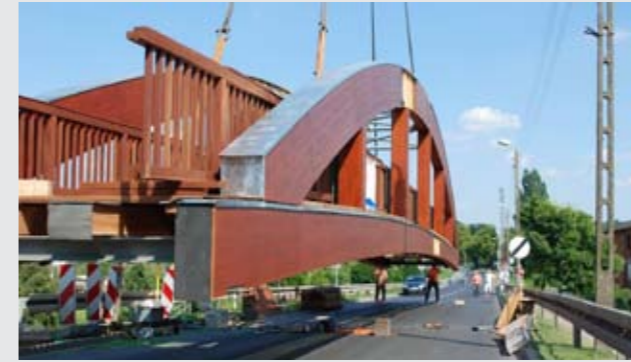
Bild 3 Brücke in Pakość mit der Länge von 38 m, Transport von zwei Teilen, Montage - 6 Stunden
