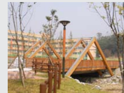
Bild 6 Brücke in Korea, 2 Brücken mit der Länge von 34 m, fertiggestellt in Deutschland und mit der Seefracht geliefert auf die Baustelle in Seoul
