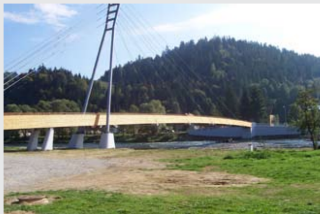
Bild 1 Czorsztyn, Brücke mit der Länge von 112 m, auf die Baustelle geliefert in 6 Fertigteilen, die Montage dauerte 4 Tage
