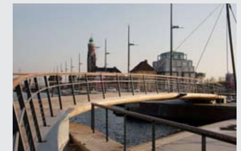
Bild 7 Lloydock, Länge 24 m, die Montage dauerte 2 Tage
