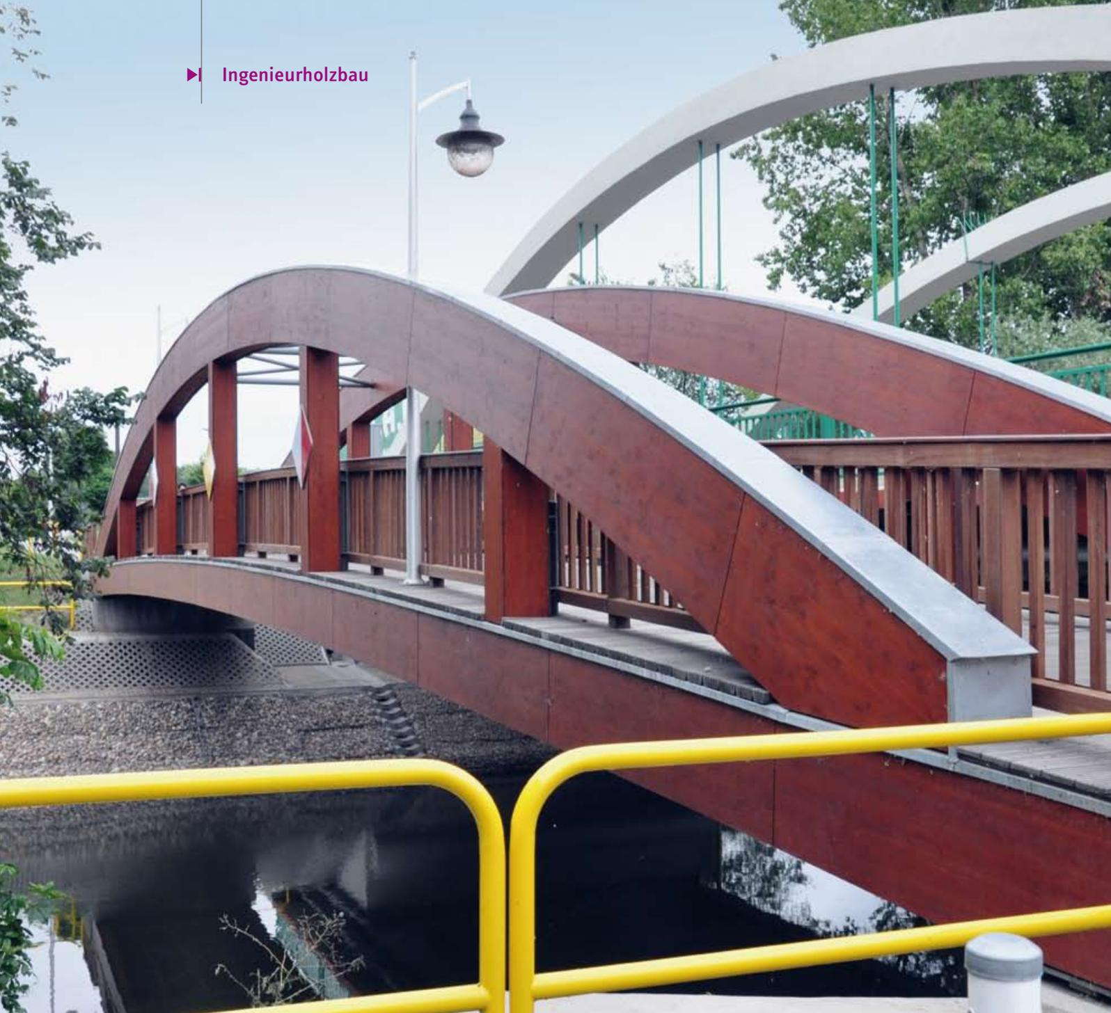
▲ Die neue Bogenbrücke spannt über 32 m. Aufgrund der Überhöhung wirkt sie leicht
