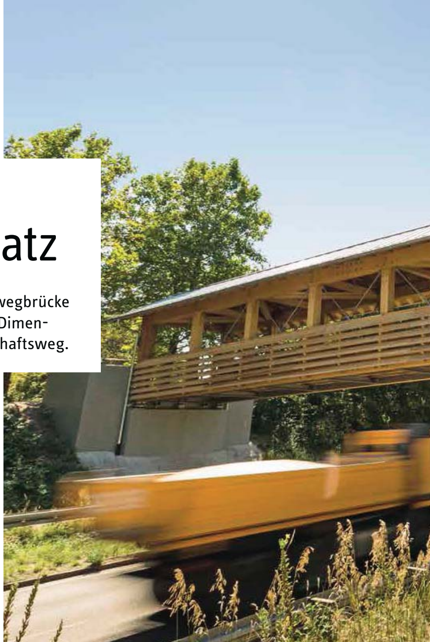
► Die 85 m lange Geh- und Radwegbrücke bei Lörrach überspannt die Bundesstraße 317
