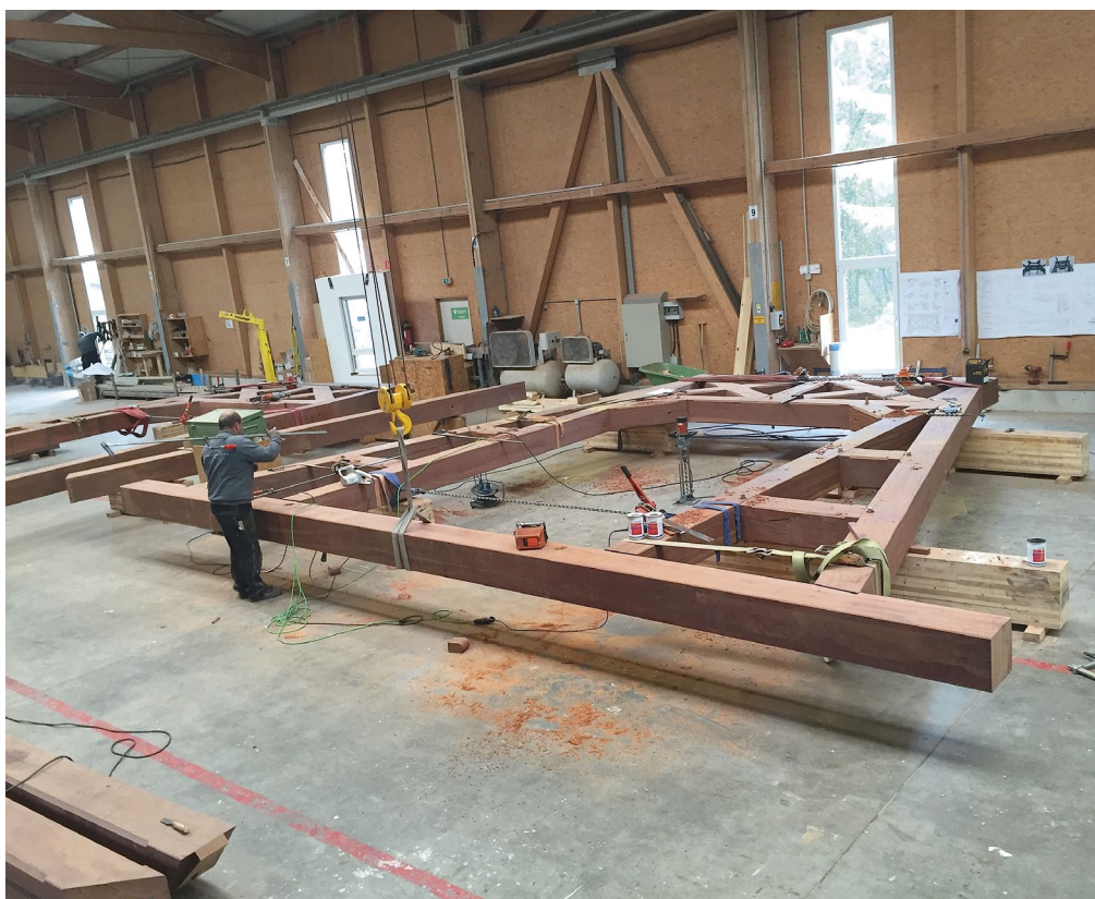
Auch die Portale wurden komplett erneuert. Viele der alten Eisenbeschläge konnten wiederverwendet werden.
