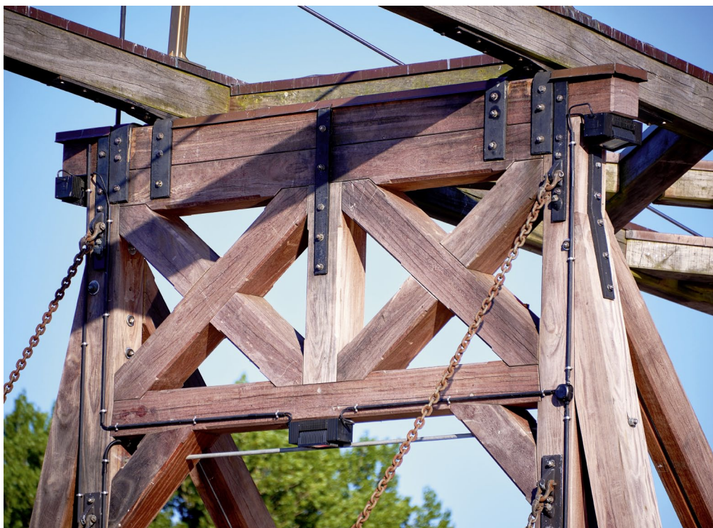
Die oberen Fachwerke in den Portalen bestehen aus kräftigen Querschnitten. Sie wurden detailgetreu wie ihre historischen Vorgänger mit zimmermannsmäßigen Verbindungen versehen.
