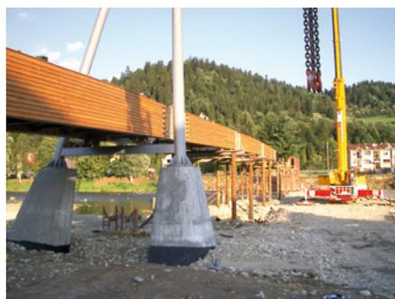
Bild 13 Die Fußpunkte des Pylons sind über spezielle Verankerungen in die Stahlbeton-Einzelfundamente eingespannt.
