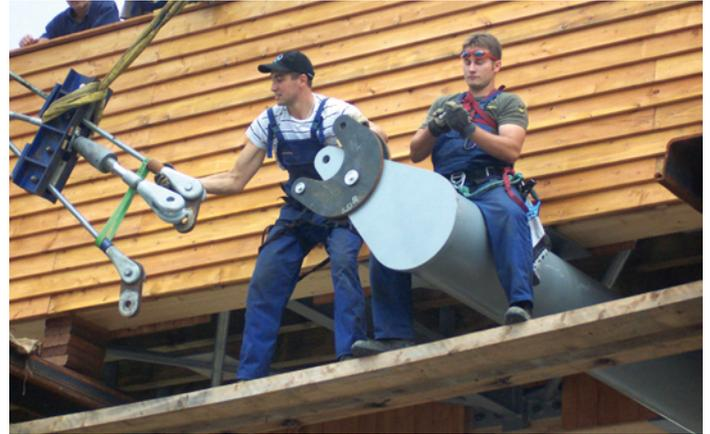
Bild 11 Anschluss eines VVS-Seiles an einen Stahlquerträger
