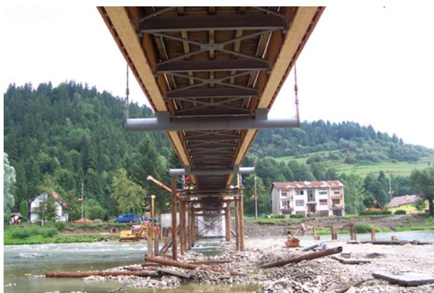
Bild 9 Brückenuntersicht mit brüstungshohen BS-Holz-Hauptträgern (siehe auch Bild 7), Stahlquerträgern, Windverbänden und Nebelängsträgern
