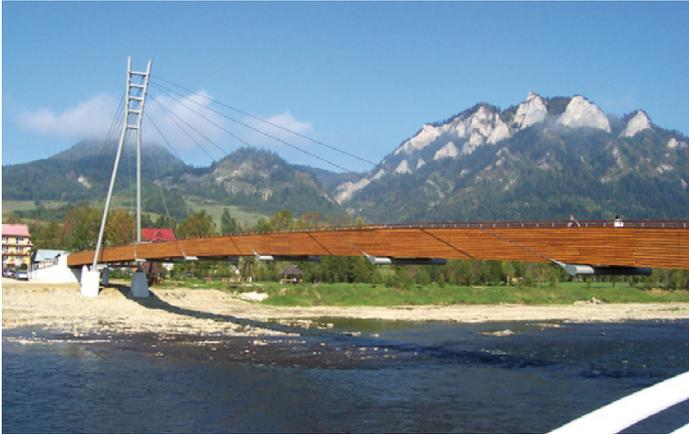
Bild 10 Fünf abgespannte Stahlquerträger tragen den Brückenüberbau
