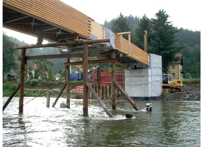
Bild 21 Das letzte Überbauelement ist montiert.
