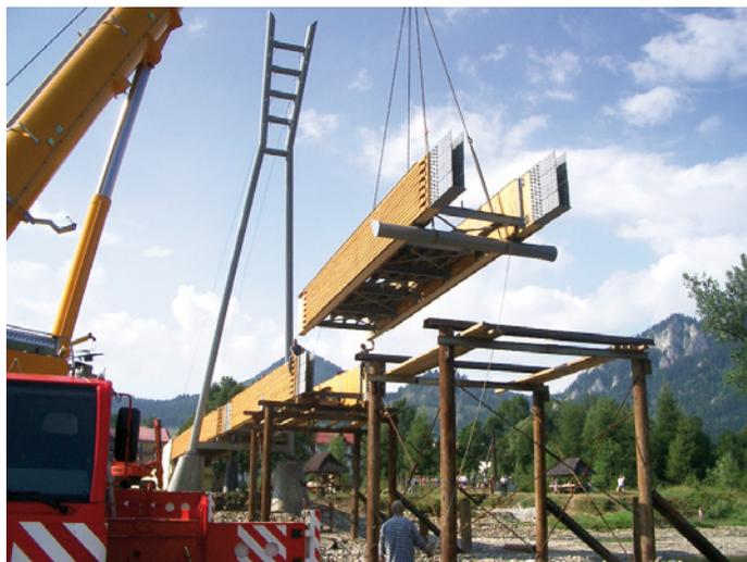
Bild 19 Montage der Überbauelemente auf Hilfsgerüsten
