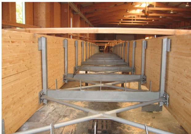
Bild 7 U-förmige Aussteifungsrahmen und eingeschweißte Windverbände
