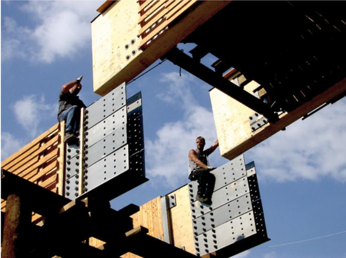
Bild 20 Zusammenführung eines Elementstoßes
