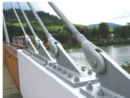
Bild 14 Verankerung der Zugstangen am Widerlager auf der polnischen Seite
