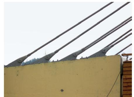
Bild 15 Vier Stahlbleche je Widerlagerflügel nehmen die insgesamt acht Zugstangen auf.
