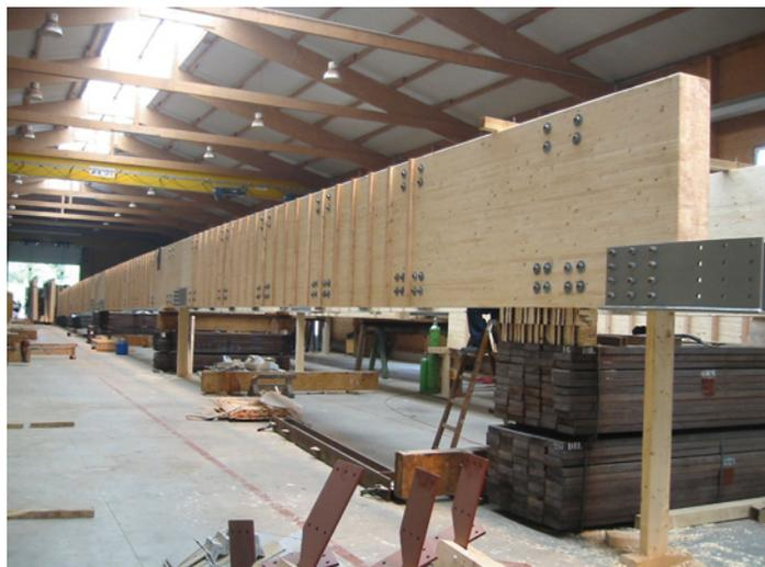
Bild 16 BS-Holz-Hauptträger mit Lattenunterkonstruktion für die spätere Verschalung
