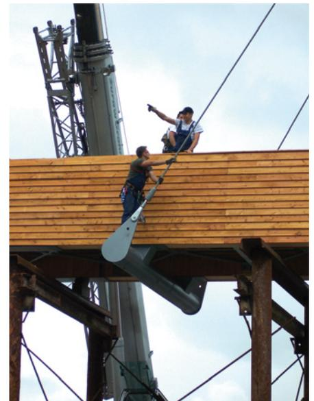
Bild 12 Montage der VVS-Seile an einen Stahlquerträger geglückt
