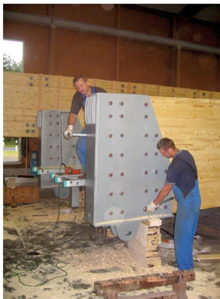
Bild 17 Vormontage der Auflagerkonstruktion
