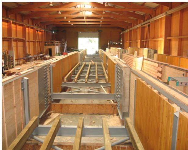
Bild 18 Teilweise auf die BS-Holz-Träger aufgebrachte Verschalung und Nebelängsträger für den Bohlenbelag der Gehbahn
