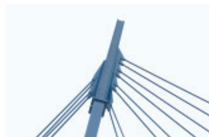
Bild 5: Kopfpunkt des Pylons: Vier Zugstangen spannen zu den Widerlagern, acht zum Brückenmittekteil.
