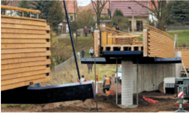
Bild 15: Montage eines Brückenteils an ein Widerlager. Eingeschlitzte Gelenkbleche verbinden später die Brückenteile.
