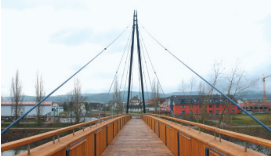
Bild 1: Abspannungen hängen die Gehbahn am Stahlpylon auf. Fußgänger und Radfahrer fädeln durch die perspektivische Wirkung regelrecht in die Brücke ein.
