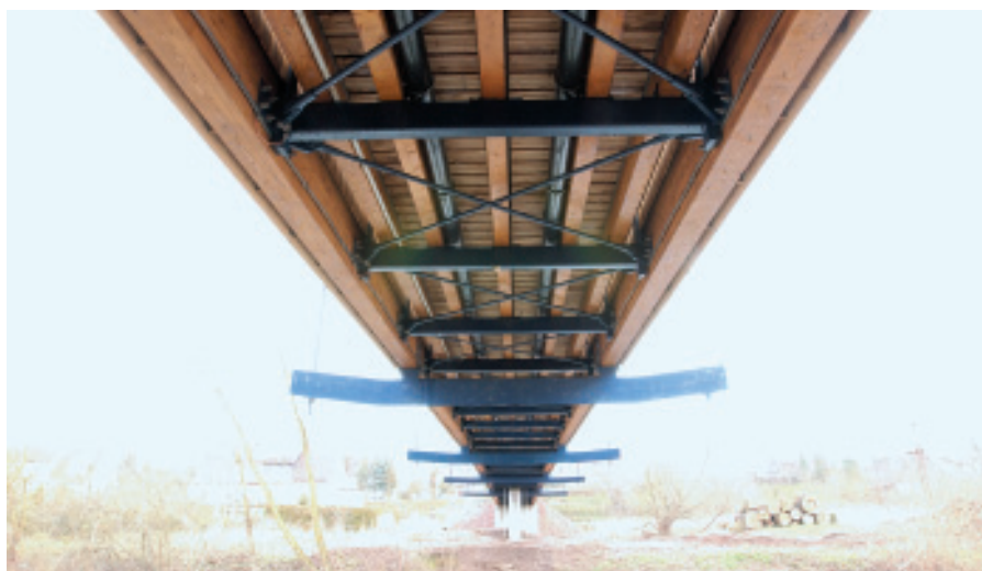
Bild 4: Die Brückenuntersicht gibt die Statik preis: Die seitlichen, 1,60 m hohen Hauptträger fassen stählerne Querrahmen, zwischen denen die Windverbände angeordnet sind. Auf fünf Nebenträgern sind die Bohlen der Gehbahn aufgebracht.
