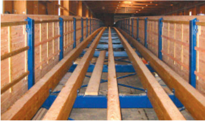
Bild 9: Vorfertigung im Werk: Die stählernen Querrahmen verbinden die Hauptträger. Fünf Nebenträger (weiter Bild 10) ...
