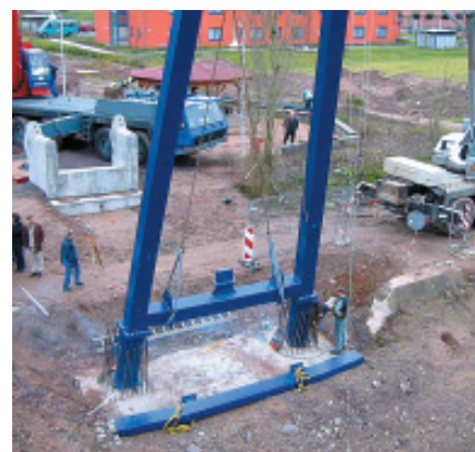
Bild 6: Der A-förmige Stahlpylon wird in Stahlbetonfundamente eingegossen.
