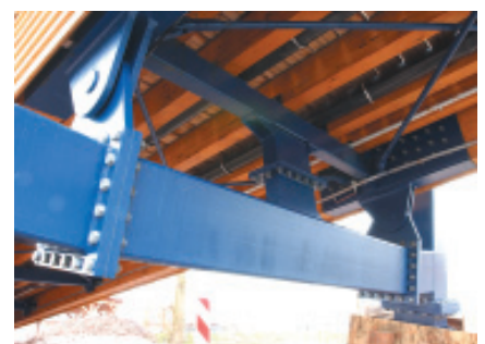
Bild 14: Anschluss der Gehbahn an den A-förmigen Pylon
