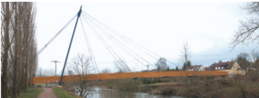
Bild 2: Seitenansicht der knapp 75 m langen Brücke. Die Pylon-Neigung: etwa 75°
