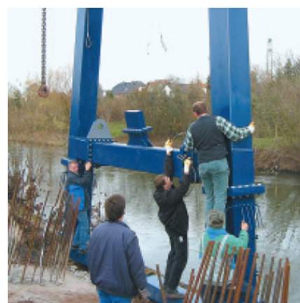
Bild 7: Am Querriegel des Pylons sitzen die Anschlusssteile für die Gehbahn (siehe auch Bild 14).
