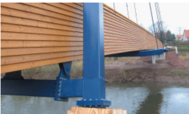
Bild 12: Konstruktiver Holzschutz der Hauptträger durch eine hinterlüftete Lärchenholzschalung
