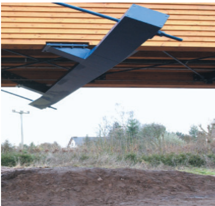
Bild 11: Jeder der vier Stahlquerträger muss mit einer anderen Neigung an die hölzernen Hauptträger angeschlossen werden, da die Zugstäbe senkrecht an ihnen anschließen.
