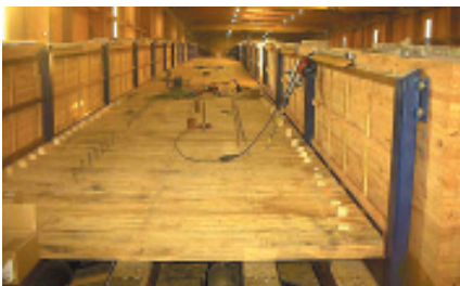
Bild 10: ... dienen schließlich als Untergrund für den Eichenbohlenbelag der Gehbahn, den man mit einer Fuge von etwa 1 cm verlegte.
