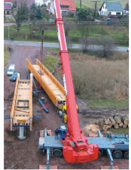
Bild 13: Schwerlasttransporter bringen die vorgefertigten Brückenteile.
