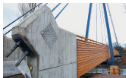
Bild 8: Die Zugstangen des Pylons zum Widerlager sind im Beton verankert und können dort nachgespannt werden.
