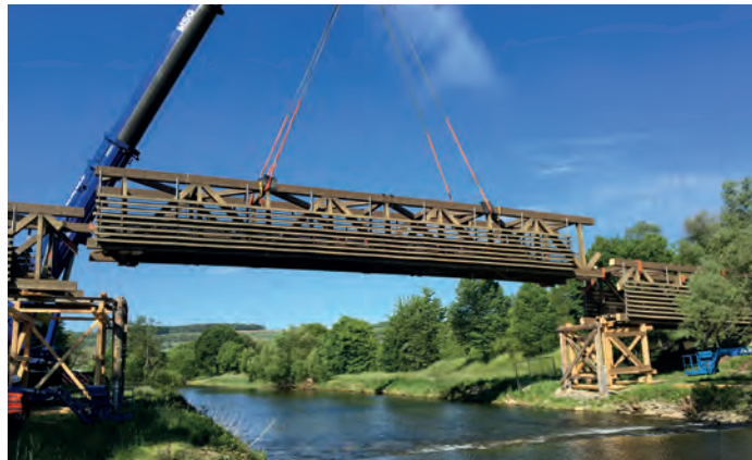
17 Demontage des alten Überbaus © Schmees & Lühn Holz- und Stahl Ingenieurbau GmbH & Co. KG
