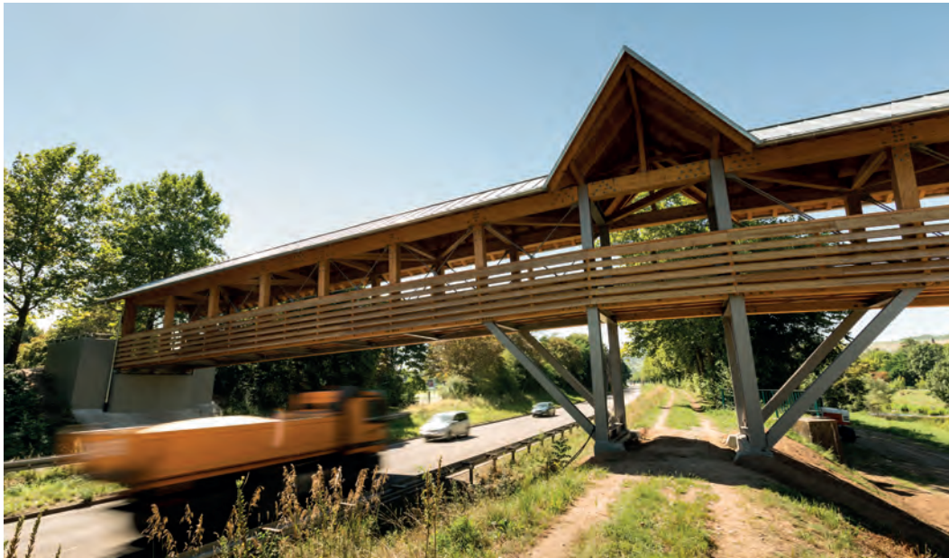
22 Neues Querungsbauwerk nach Fertigstellung © Markus Ruf
