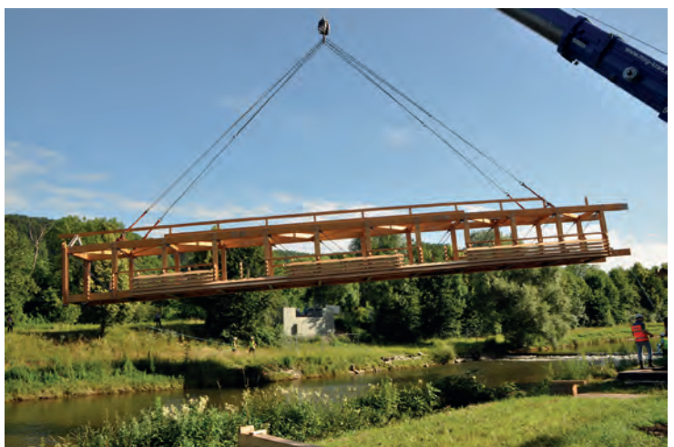
17 Demontage des alten Überbaus © Schmees & Lühn Holz- und Stahl Ingenieurbau GmbH & Co. KG
