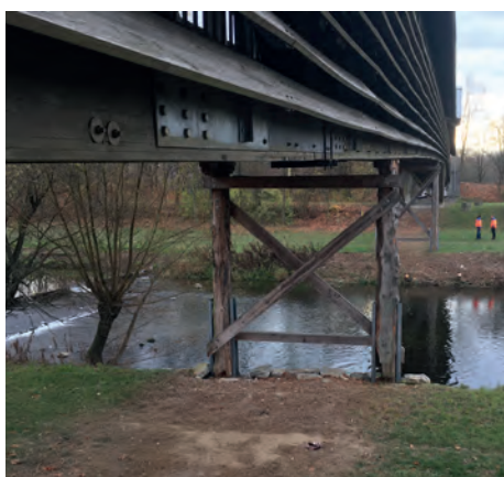
2 3 Ungeschützter Untergurt mit Fäulnisschäden © Schmees & Lühn Holz- und Stahlingenieurbau GmbH & Co. KG
