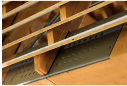
11 Ausgeführter Zuganschluss © Schmees & Lühn Holz- und Stahlgenieurbau GmbH & Co. KG
