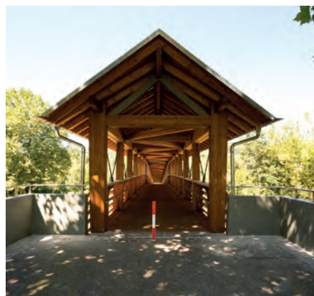
20 21 Tragstruktur mit Pfettendach und Bohlenbelag © Markus Ruf
