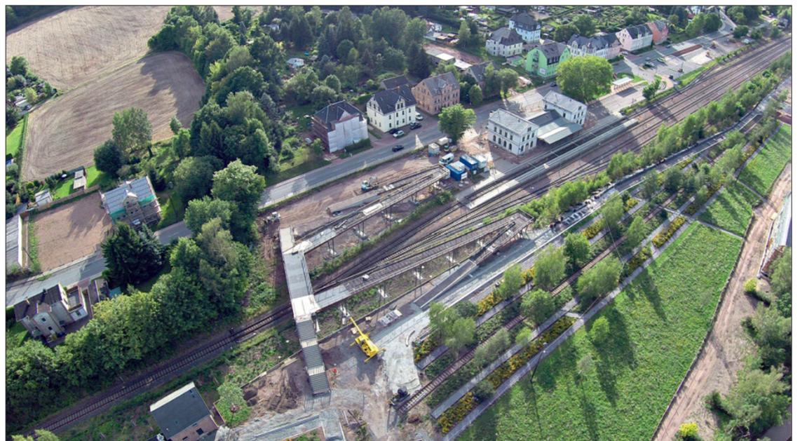
Luftaufnahme des Brückenbauwerks am Haupteingang zur Landesgartenschau Oelsnitz: Die Hauptbrücke überspannt die Gleise des alten Verschiebebahnhofs. Von ihr gehen zwei Treppen und zwei Nebenbrücken mit Rampen ab. Die abgewinkelte Länge beträgt 170 m
