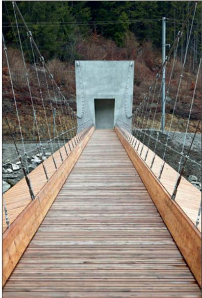
Die lichte Breite der Gehbahn misst mit 1,80 m die Hälfte der Gesamtbreite von 3,60 m. Um die Windangriffsfläche der Hängebrücke zu reduzieren, fallen die Längsträger-Querschnitte beidseitig nach außen ab. Sie bilden eine spitze „Windnase“
