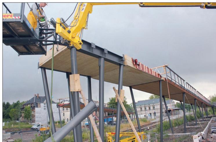
Das Haupttragwerk ist eine Stahlkonstruktion und nimmt die Gehbahn aus blockverklebten Brettschichtholz-Elementen auf. Hier die Montage einer der Nebenbrücken
