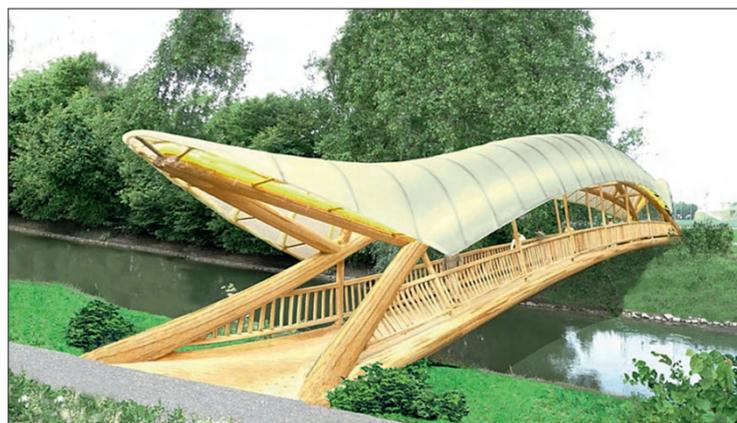
Das Haupttragwerk der 4 m breiten Aubrücke Opfikon bilden zwei gegeneinander gelehnte Brettschichtholz-Bögen und Konstruktionshölzer aus Lärche. Ein Membrandach überspannt die Konstruktion
