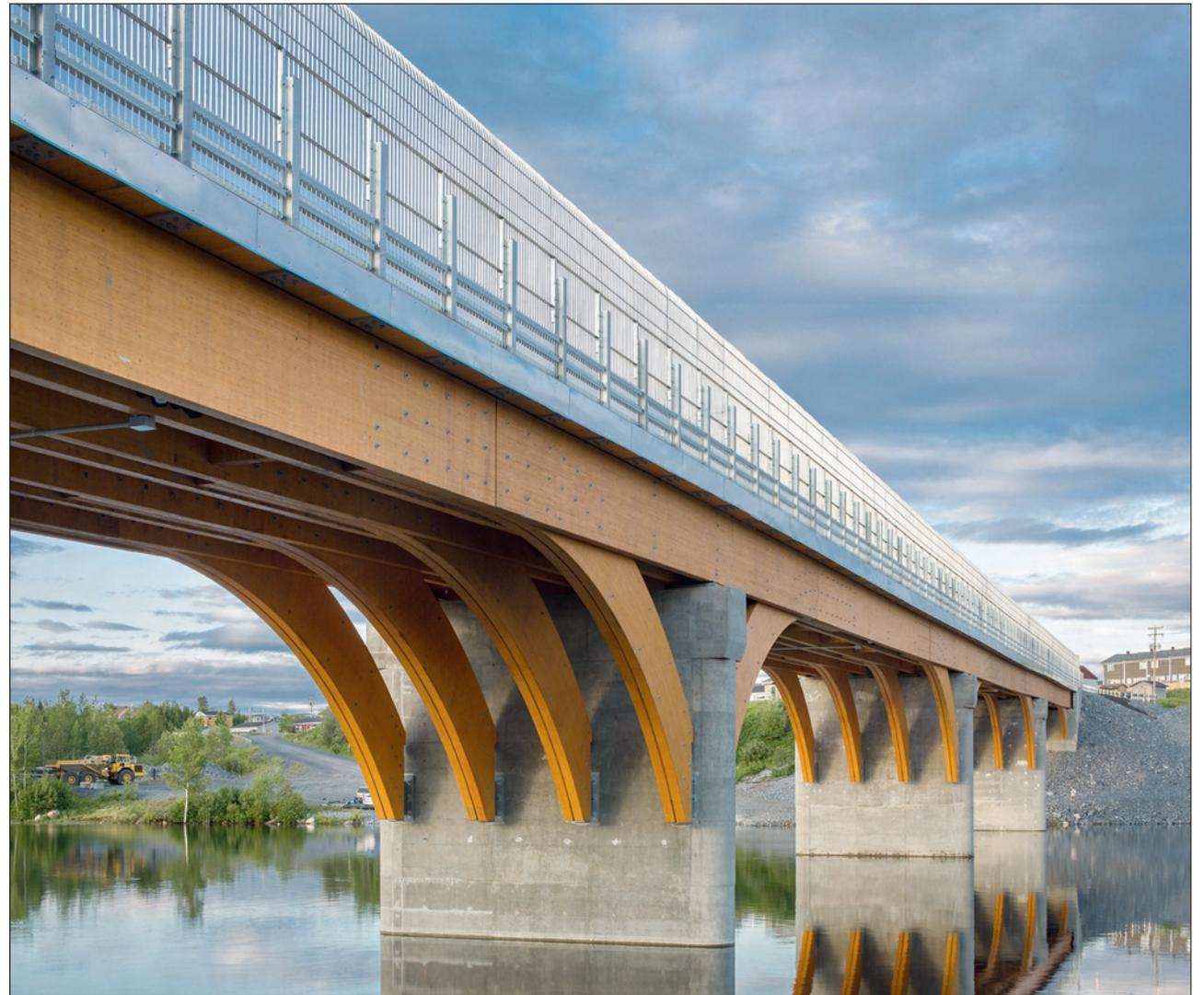
Das Tragwerk der Mistissini-Brücke mit vier Feldern bilden gestoßene Längsträger, deren Teillängen kürzer sind als die Feldlängen. Mit Hilfe von Bogenbindern können sie montiert werden, über die Bögen stützen sie sich an den Brückenpfeilern und Widerlagern ab. Sie sind jeweils zwischen zwei Längsträgern eingefügt und über Stahlplatten seitlich biegesteif an sie angeschlossen, die Bogenfußpunkte sind dagegen gelenkig ausgeführt
