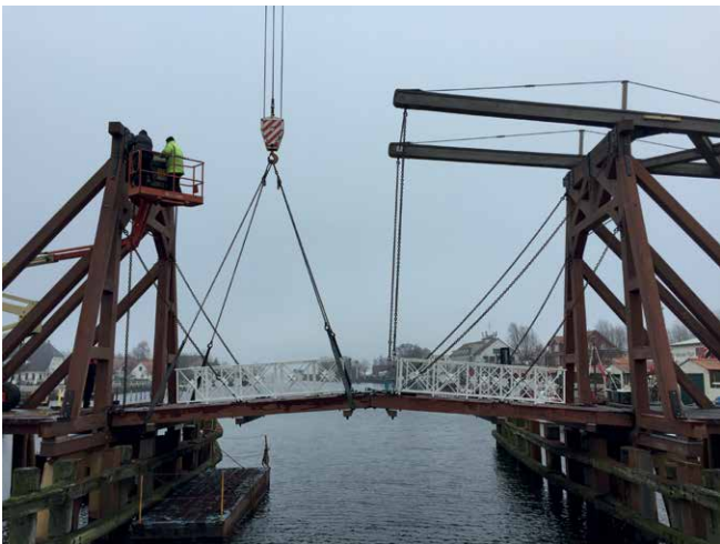
18 19 20 21 Montage in Greifswald: Portal, Klappen und Waagebalken © Schmees & Lühn GmbH & Co. KG
