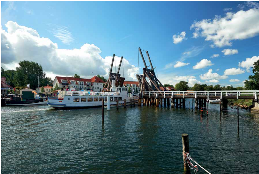
22 Wiecker Klappbrücke im geöffneten Zustand © Stefan Denise
