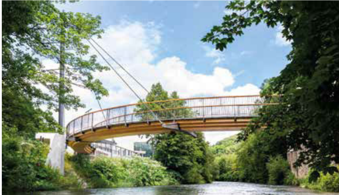
1 Viertelkreisförmig geschwungene Holzbrücke mit Schrägseilabspannung © Ingenieurbüro Miebach
