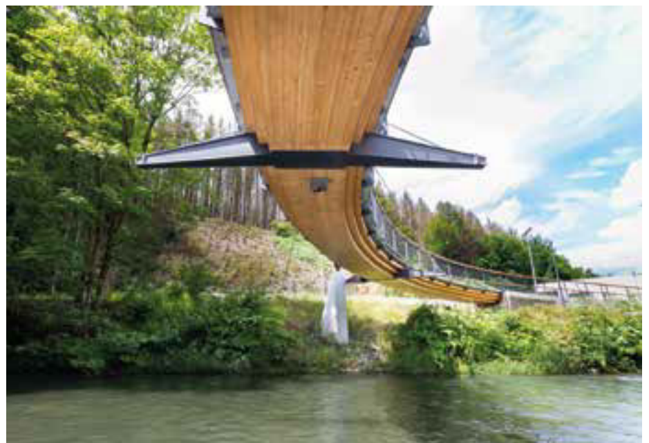
2 Überbau aus getrepptem Brettschichtholzträger © Ingenieurbüro Miebach
