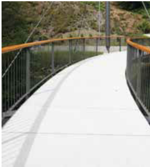
8 Großformatiger Granitbelag über die gesamte Brückenbreite © Ingenieurbüro Miebach
