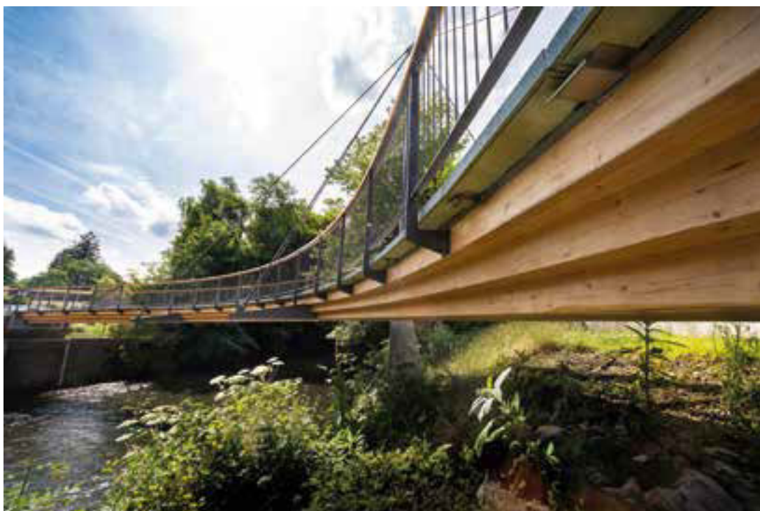
7 Edelstahlrinnen unter den Plattenstößen zur Querentwässerung © Ingenieurbüro Miebach
