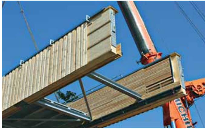
Eines von drei Brückenteilen am Mobilkran, vorne sind die Montagestöße gut sichtbar, ebenso die innere und äußere Verschalung
