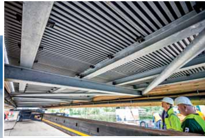
Blick auf die Brückenunterseite mit dem Stahl-Nebentragwerk zwischen den BSH-Hauptträgern
